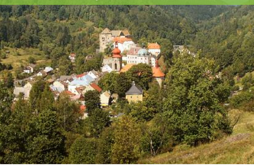
Bečov nad Teplou
